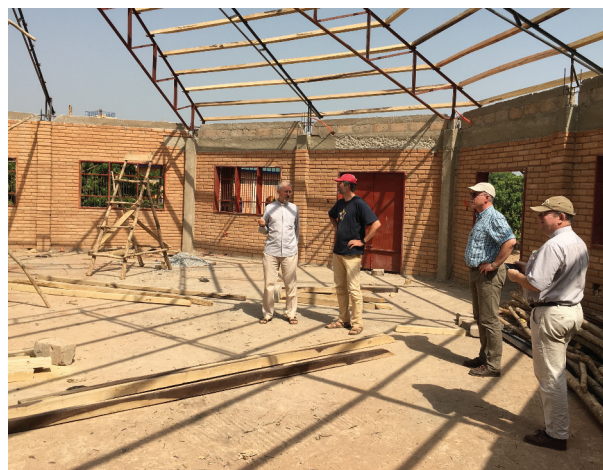
▼ Construction du bâtiment communautaire au séminaire de Gaa Baka
